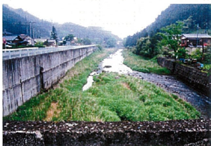
住宅地沿いに見られるコンクリート護岸
