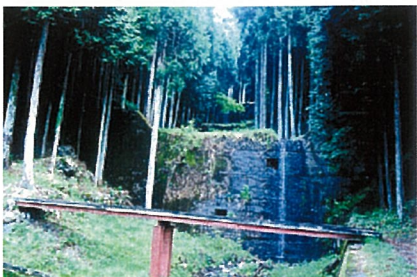
ところどころに見られる砂防ダム
