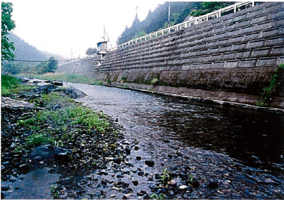
コンクリートが露出する護岸
